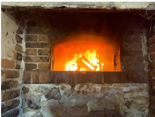
Un test d'étanchéité réalisé le 9 octobre dernier a montré que : le four est bien fonctionnel ; seule une fuite existe à la jonction du mur d'enceinte mais latéralement ; les dégradations visuelles de la voûte n'altèrent pas l'étanchéité de celle-ci.
