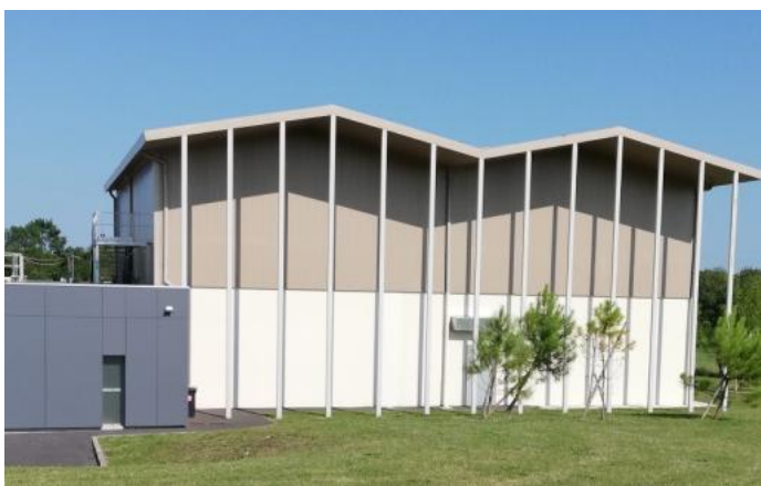
Usine d'ultrafiltration, Barzan
