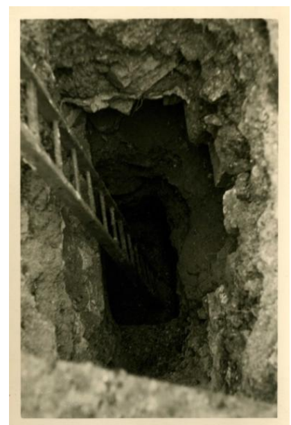
Puits d'aération Photo, L.Basalo
