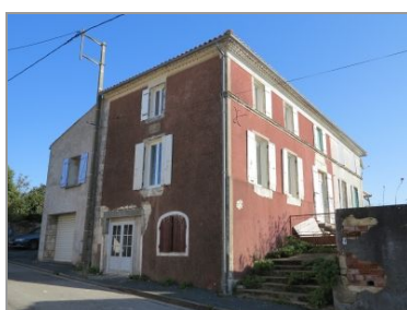
Maison dite rurale avec chai en soubassement, dans le bourg.
