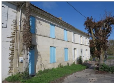
Maisons à un étage, avec bandeau et corniche, aux Monards.
