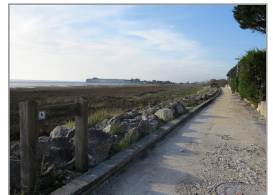
Barzan-Plage : promenade et digue de protection.
