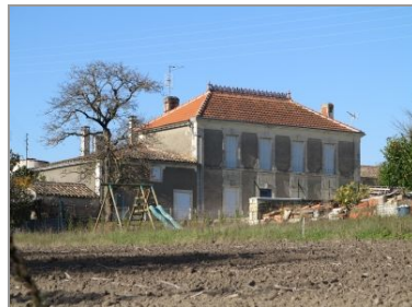
Maison de maître, Chez-Grenon.
