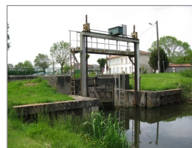
L'écluse de chasse des Monards.
