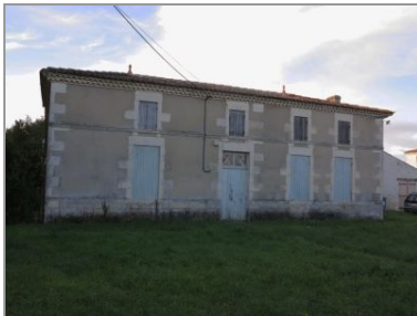
Logis de ferme avec toit à croupes, génoise double et bandeau, aux Perrotins.
