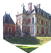
Château à Saint-Rémy-en-l'Eau
