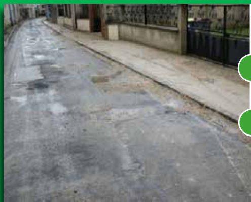
enfouissement des réseaux
