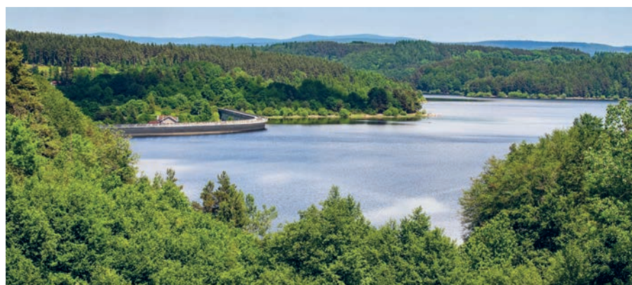
Le barrage de Lavalette
