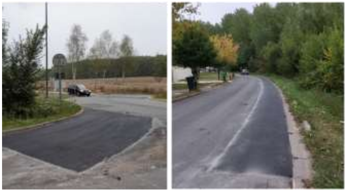
Rénovation de la voirie, rue de Folleville
