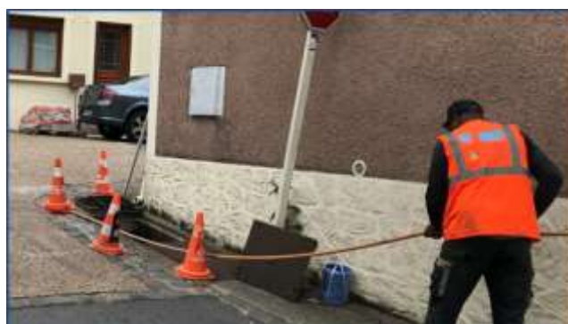
Figure 2 - tirage de fibre optique depuis une trappe dans la rue
