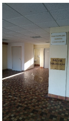
Création de toilettes pour PMR à la Salle Alfred Lucas
