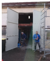
Changement de la porte du dépôt.
