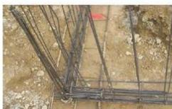
Nœud de chaînage - Continuité mécanique
