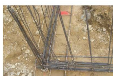
Nœud de chaînage - Continuité mécanique
