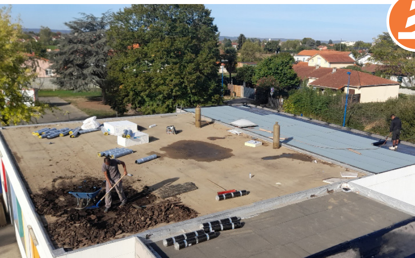
Novembre 2022. Travaux de rénovation sur la toiture de l'école élémentaire des Cèdres.
