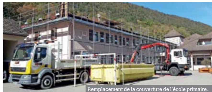
Remplacement de la couverture de l'école primaire.
