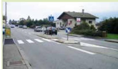
Le passage protégé situé au niveau du centre commercial des Riondettes a été mis aux normes d'accessibilité aux handicapés. Des barrières partielles restent à poser de part et d'autre de l'îlot central pour améliorer la sécurité de la traversée de la route. Un abaissement du trottoir est prévu du côté du chemin de La Liaz pour assurer la continuité de déplacement des personnes en fauteuil roulant.
