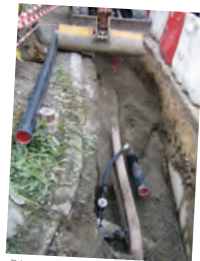
Rénovation programmée de la distribution dans le hameau de Chuguet. Une autre vient de commencer au chemin du Mulot.
