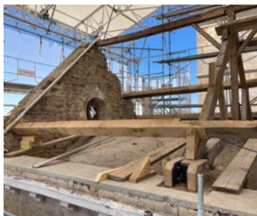
démolition de la charpente
