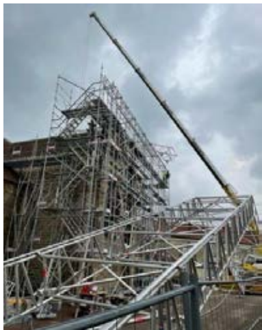
Mars 2022 : pose échafaudages
