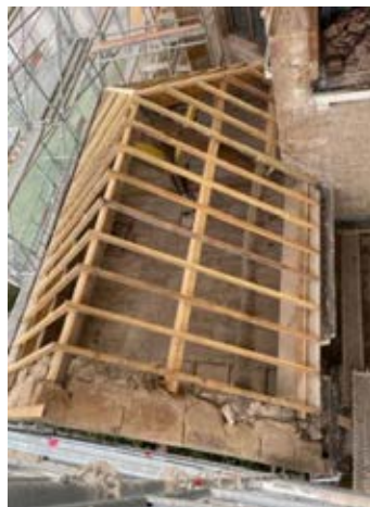
novembre 2022 : réhabilitation de la toiture de la sacristie
