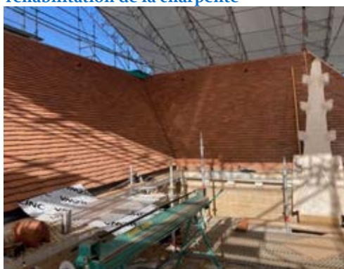
24 octobre 2022 : pose des tuiles plates
