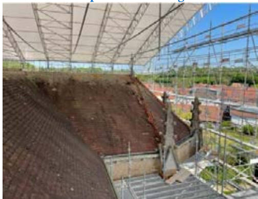
3 mai 2022 : parapluie installé
