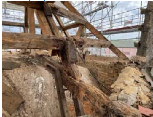
20 mai 2022 : état de la charpente avant travaux
