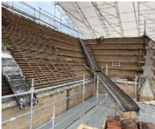
22 septembre 2022 : évolution des travaux
