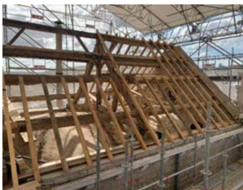
réhabilitation de la charpente
