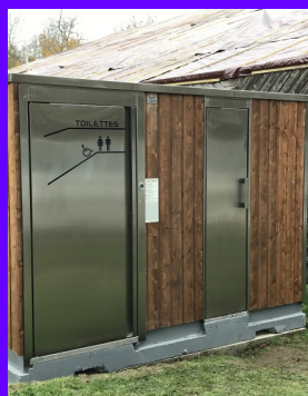
Mise en service des toilettes publiques
