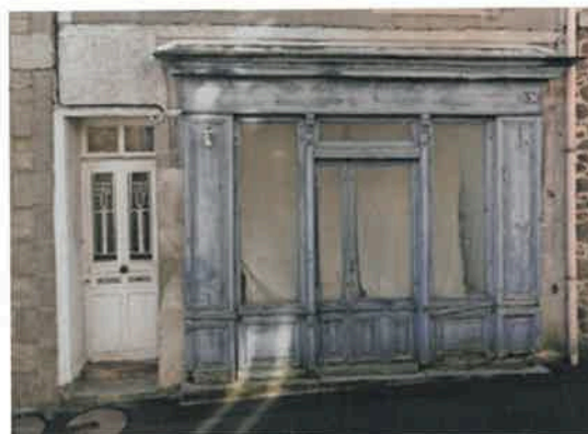
Une vitrine fermée à Plancoët Source : PLUiH de Dinan Agglomération, 2021
