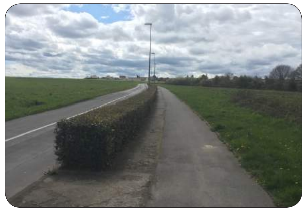
La voie cyclable de la rue du Bois Clair (crédit photo : A4PLUSA)
