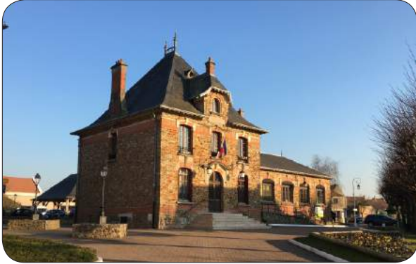
La mairie de Nozay (crédit photo : A4PLUSA)
