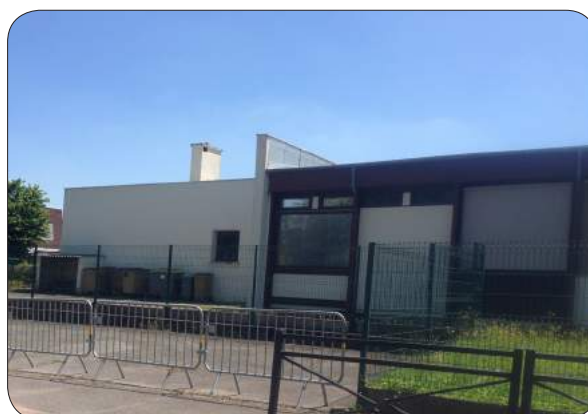
École les Clozeaux (crédit photo : A4PLUSA)
