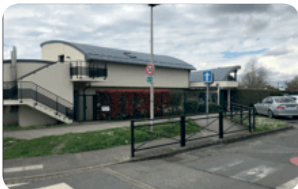
Le gymnase du COSEC (crédit photo : A4PLUSA)
