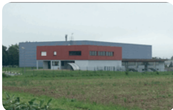
La Halle des Sports (crédit photo : A4PLUSA)
