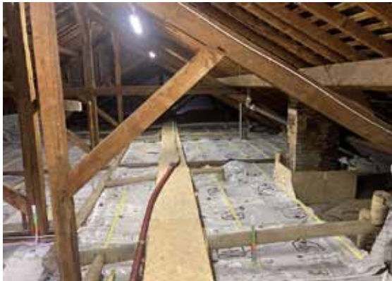
Isolation des combles de l'école maternelle.
