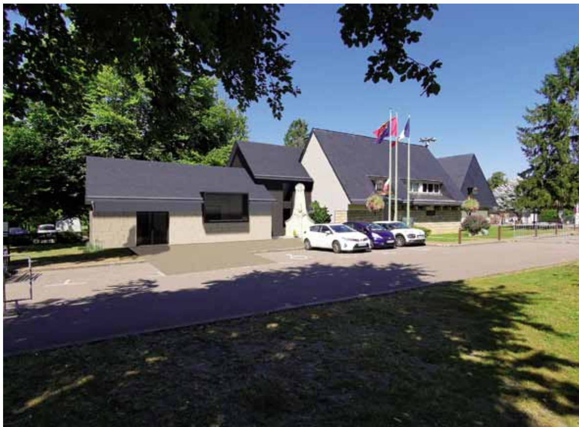
Le projet d'extension de la mairie. © François Meuric / Atelier Architecture A2B / Offranville
