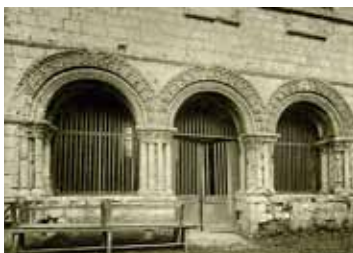
La salle capitulaire avant les transformations.
