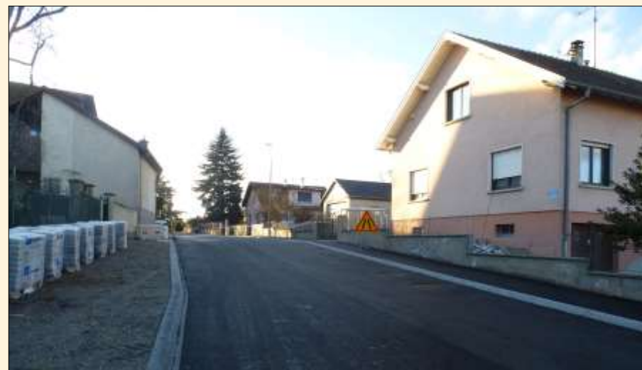
Pendant : les travaux touchent à leur fin
