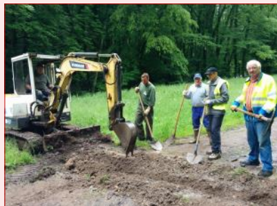
Pose de bois d'eau en forêt
