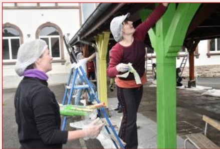
Peinture des poteaux du préau de l'école
