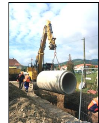
Septembre Travaux en vue de l'évacuation des eaux pluviales des rues des Oiseaux et de la Cote 425
