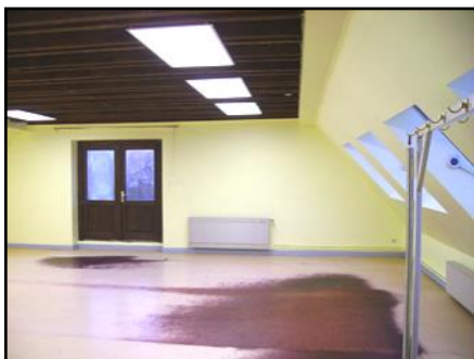
Février La Salle de Musique en cours de restauration (des panneaux acoustiques ont été posés ; peinture des poutres, des murs, du plafond, de la porte et du balcon)
