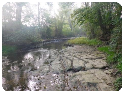
Apparition du substratum après purge des alluvions sur la Toranche aval
