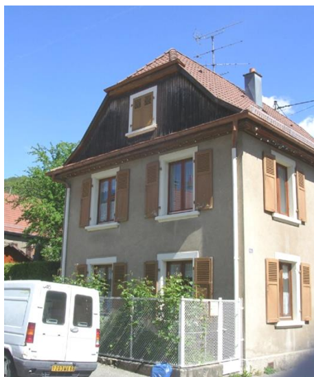
Maison caractéristique de la reconstruction du noyau villageois ancien : pignon sur rue et toit en demi-croupe, symétrie des ouvertures.
