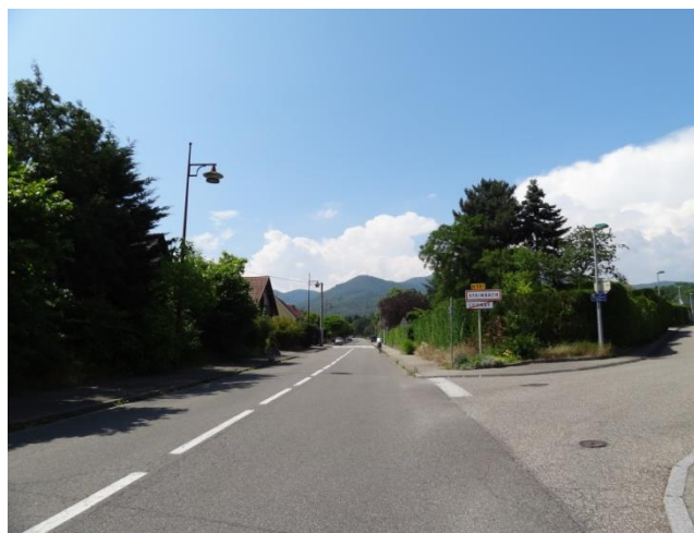
Entrée de ville Sud-Est par la D35 II
