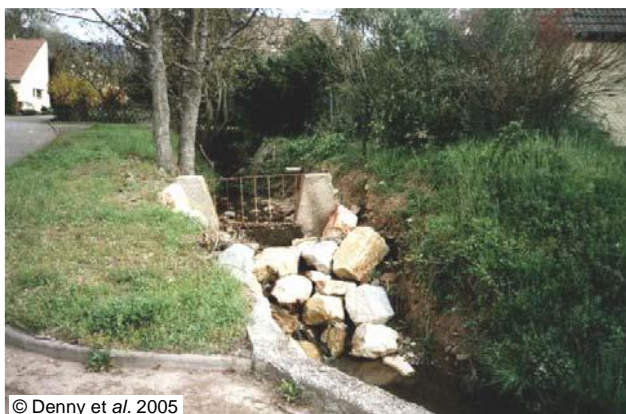
Débouché du Welnachtbach sur le fossé longeant la RD 35. Dans l'objectif de stabiliser momentanément son débouché sur la RD 35, une chute enrochée a été constituée.
