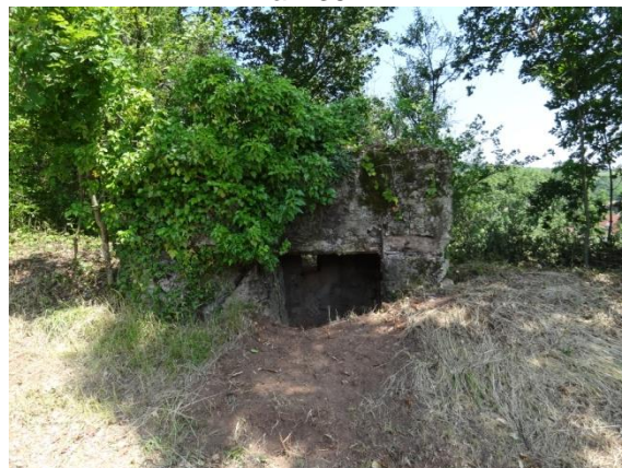
Bunker, en bordure de chemin sur le coteau du Weilnacht
