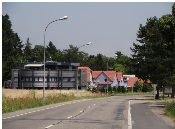
Constructions neuves à l'entrée du village le long de la D35
