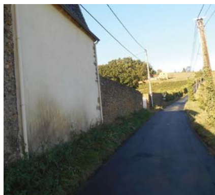
Reprise de purges sur la chaussée Montée Saint-Claude.
