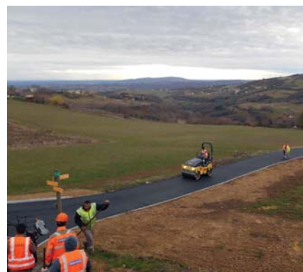
Réfection de la chaussée Montée de la Roche.
