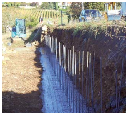
Réfection du mur Route du Bois du Chêne.
