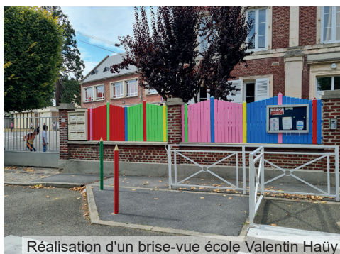
Réalisation d'un brise-vue école Valentin Haüy
