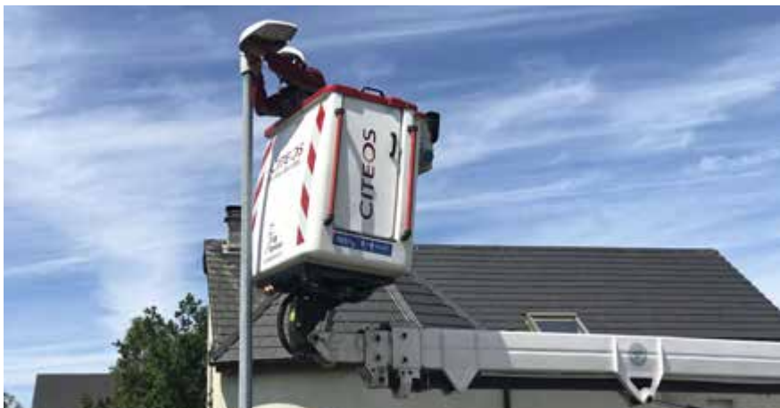
La Commune a continué le remplacement des ampoules d'éclairage public en passant au LED moins énergivore.
