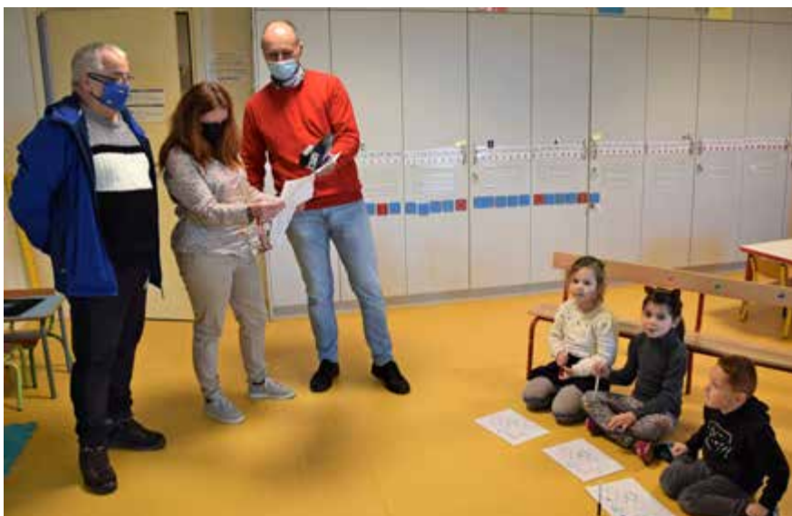
Installation de capteurs de CO 2 dans toutes les classes du groupe scolaire.
