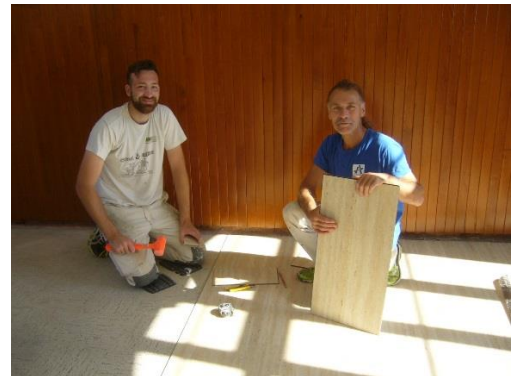
La réfection des sols des classes du rez-de-chaussée de l'école élémentaire
