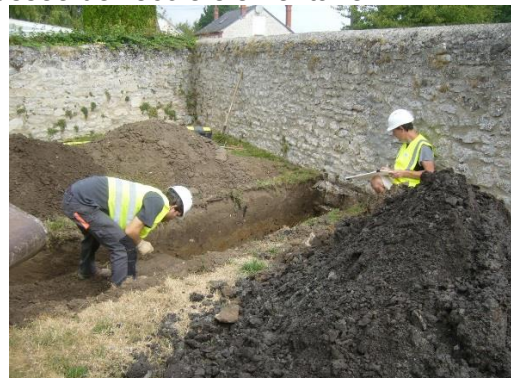
Des fouilles archéologiques ont été nécessaires avant la pose du modulaire à l'école
