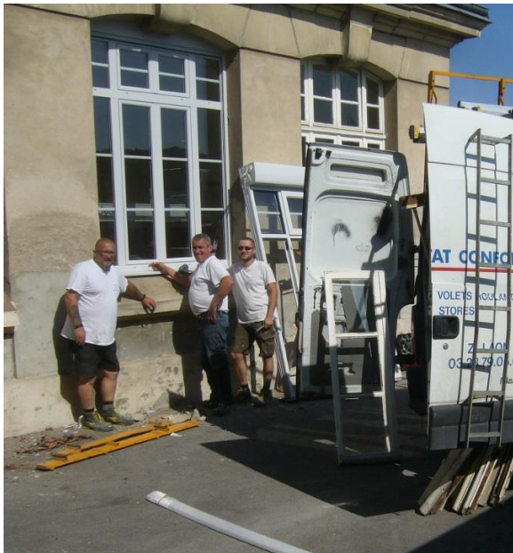
Le remplacement des huisseries à l'école primaire
