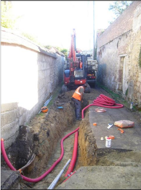
L'enfouissement des réseaux de la rue des Etuves
