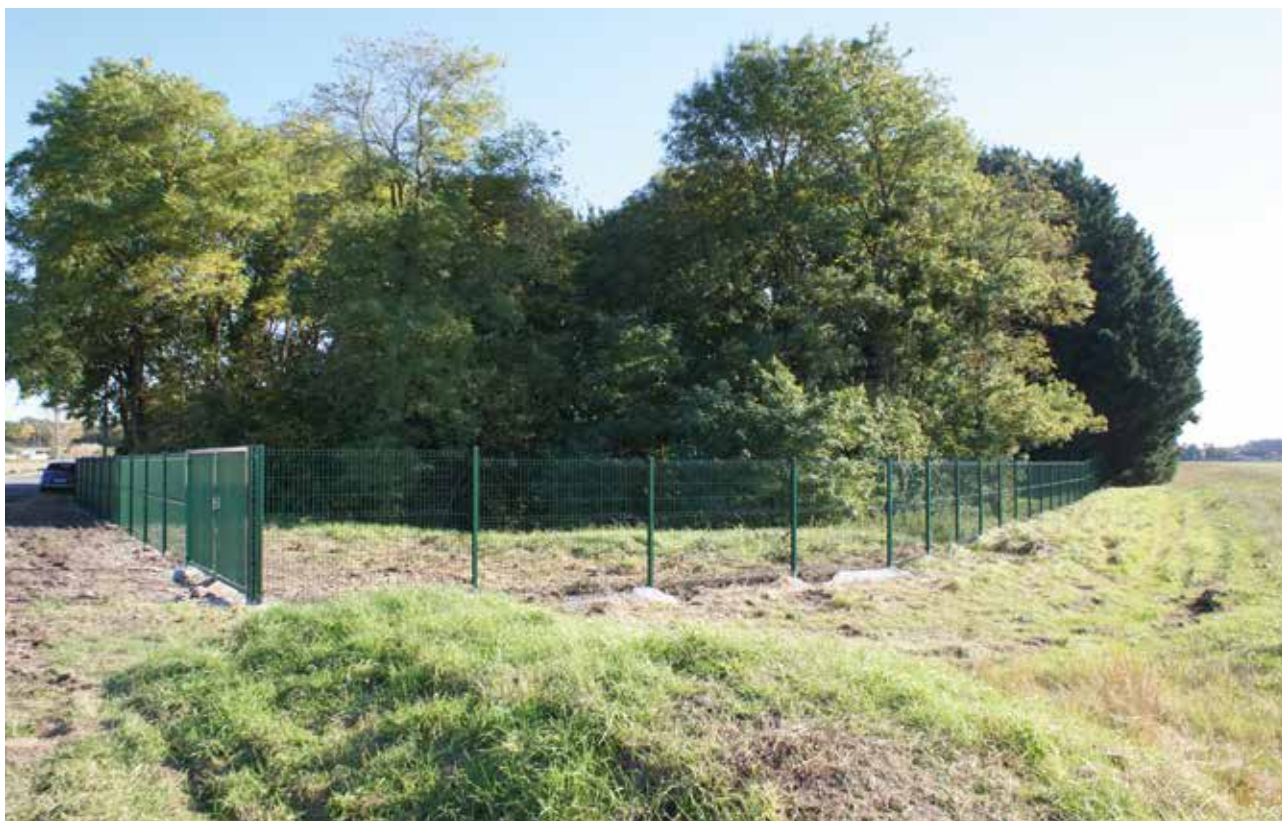
Travaux de clôture pour sécuriser le gouffre.
