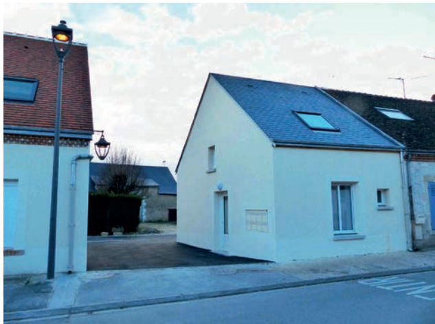
Entrée côté 50 rue Malvouiers : accès cabinet infirmières dans le passage
