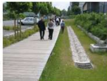
Noue de stockage à Clichy-sous-Bois
