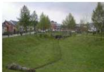
Bassin d'infiltration enherbé
