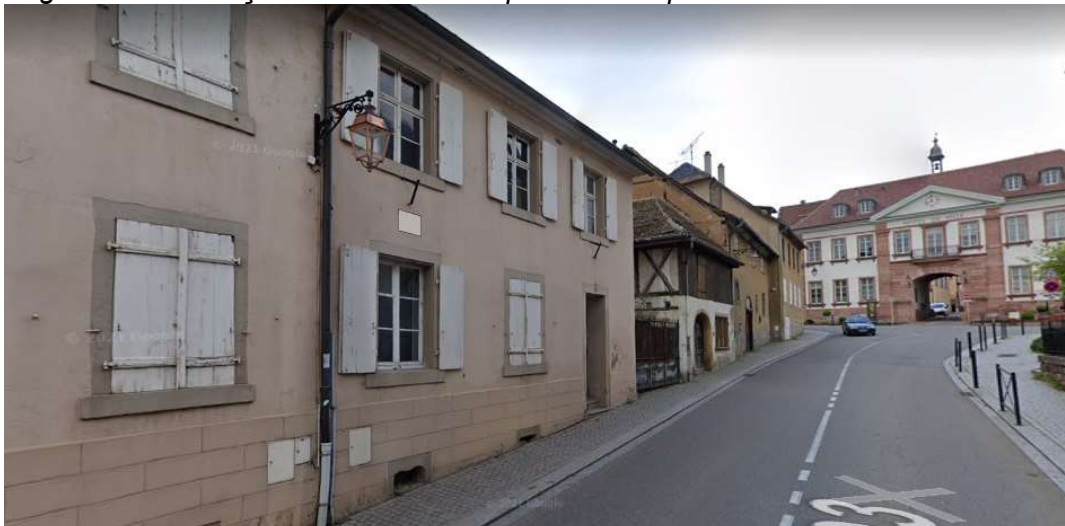
Alignement des façades de la rue Jacques Preiss qui débouche sur l'hôtel de Ville
