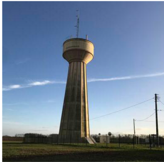
Le syndicat des eaux a baissé la redevance de 20 centimes du mètre cube pour l'assainissement.
