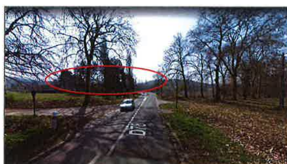
Vue du site depuis la RD78 au nord
