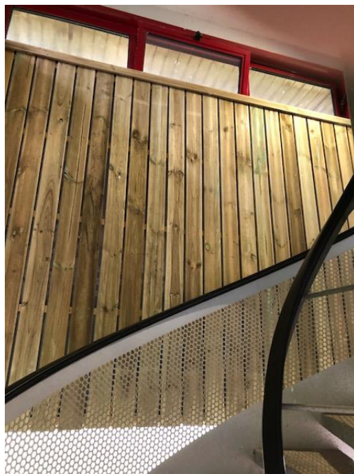
Pose d'un bardage en bois dans la montée d'escalier d'accès à la bibliothèque
