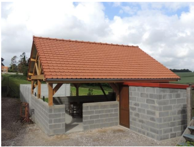
Fin des travaux portant réalisation d'un abri en bois (carbet) pouvant faire fonction d'un atelier pour les activités de l'ALSH ou de stand de tir sécurisé
