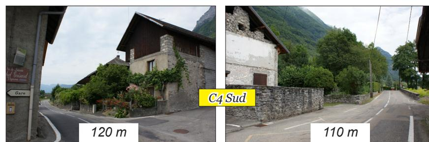
**Les distances de visibilité aux carrefours sont toutes largement supérieures aux distances minimales confortables pour des accès sûrs aux vitesses de références sur la R.D.201 et permettent d'envisager sereinement le développement de l'offre en logements dans le hameau (de ce point de vue).**
