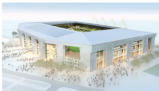
Le stade Geoffroy Guichard rénové - © « L'Atelier Tourette et Goux »
