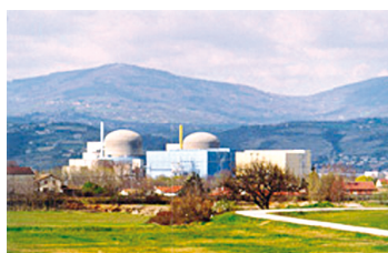
Centrale nucléaire de St-Alban St-Maurice - IRMa - Grenoble
