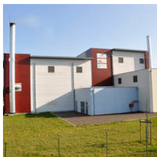
Chaufferie bois d'Andrézieux-Bouthéon - SIEL
