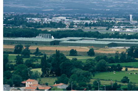
Terres agricoles à Andrézieux-Bouthéon - epures
