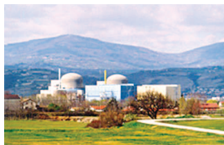
Centrale nucléaire de St-Alban St-Maurice - IRMa - Grenoble
