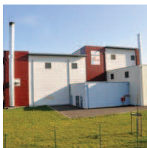
Chaufferie bois d'Andrézieux-Bouthéon - SIEL
