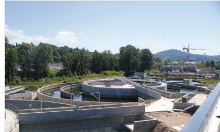
Station d'épuration Furania - Ville de St-Etienne
