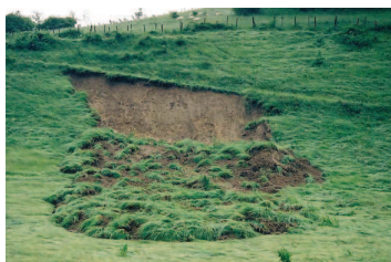
Exemple de glissement de terrain - S. Gominet
