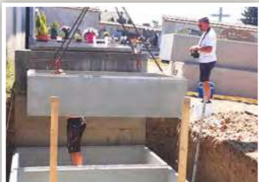
Mise en place des caveaux au cimetière
