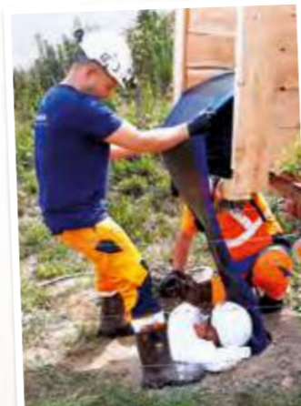
Mise en place de la gaine dans le regard. Travail très physique
