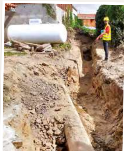
Remplacement de colonne en mode traditionnel avec des difficultés d'accès pour les engins de chantiers
