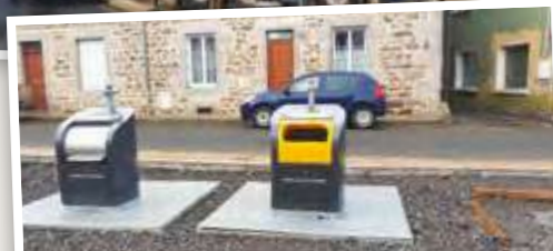
Enfouissement des poubelles de tri sélectif au centre du bourg au niveau des salles et au boulodrome
