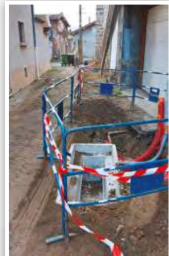
Enfouissement des réseaux secs Chemin du Pêchy suite à la démolition de la maison Bonnier.
