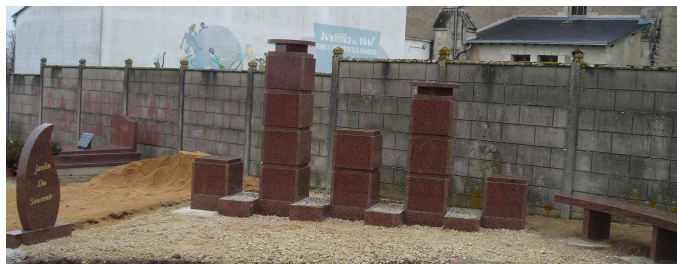
Le columbarium en cours de réalisation.
