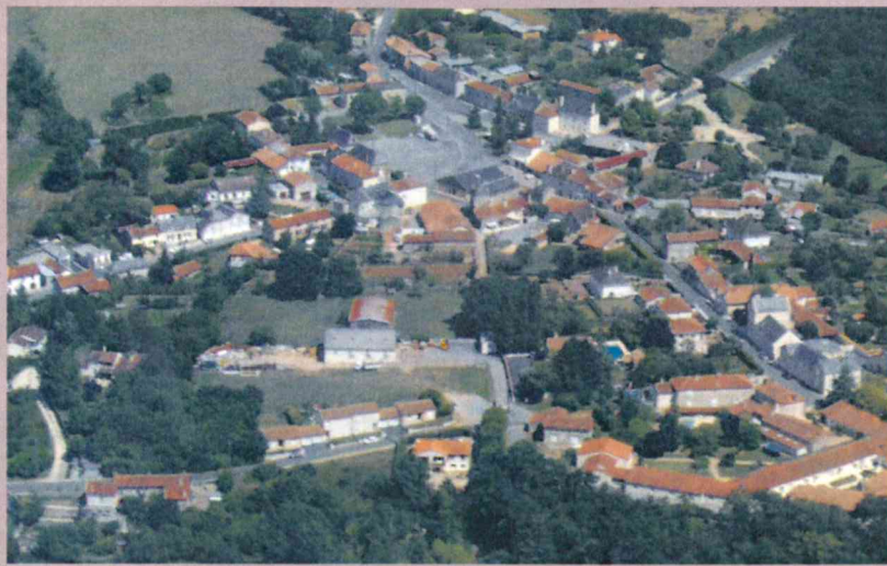
Le bourg de Château-Garnier (vue aérienne)
