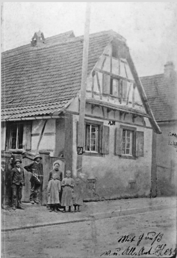
'S Hesse (Hoft démolé puis reconstruit, Rue Général Leclerc)
