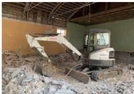
Enlèvement de la chape et du carrelage
