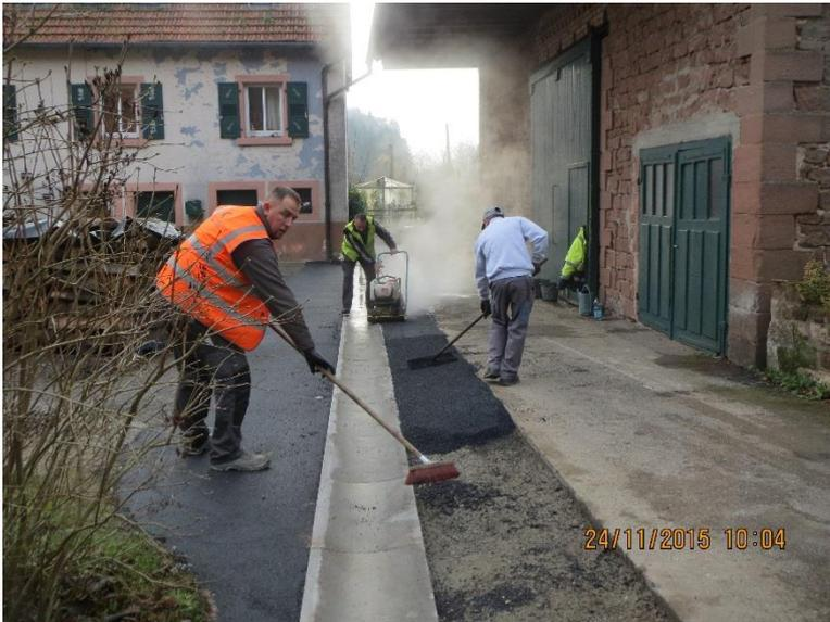
Des travaux de réfection de la chaussée étaient nécessaires sur une partie de la rue de l'Abbaye. La petite portion qui traverse la cour du n° 15, lieu de passage des camions de collecte des déchets a connu quelques dégradations et affaissement, en particulier au niveau du caniveau d'évacuation des eaux de pluie. Cet affaissement entraînait la stagnation de l'eau de ruissellement par mauvais temps et entravait ainsi le passage des riverains attenants.
