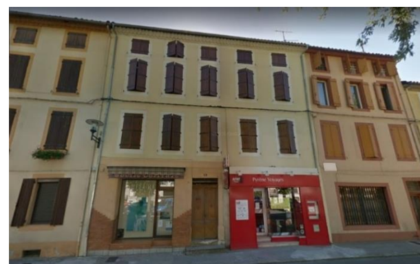
Immeubles bourgeois à Lavelanet
