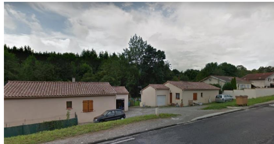
Pavillons en périphérie du village de l'Aiguillon
