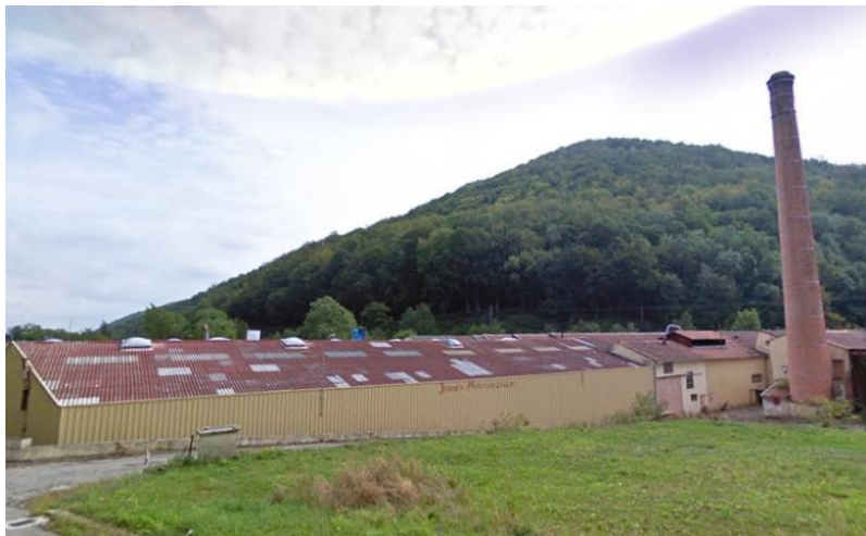
Bâti industriel sur la commune de Montferrier
