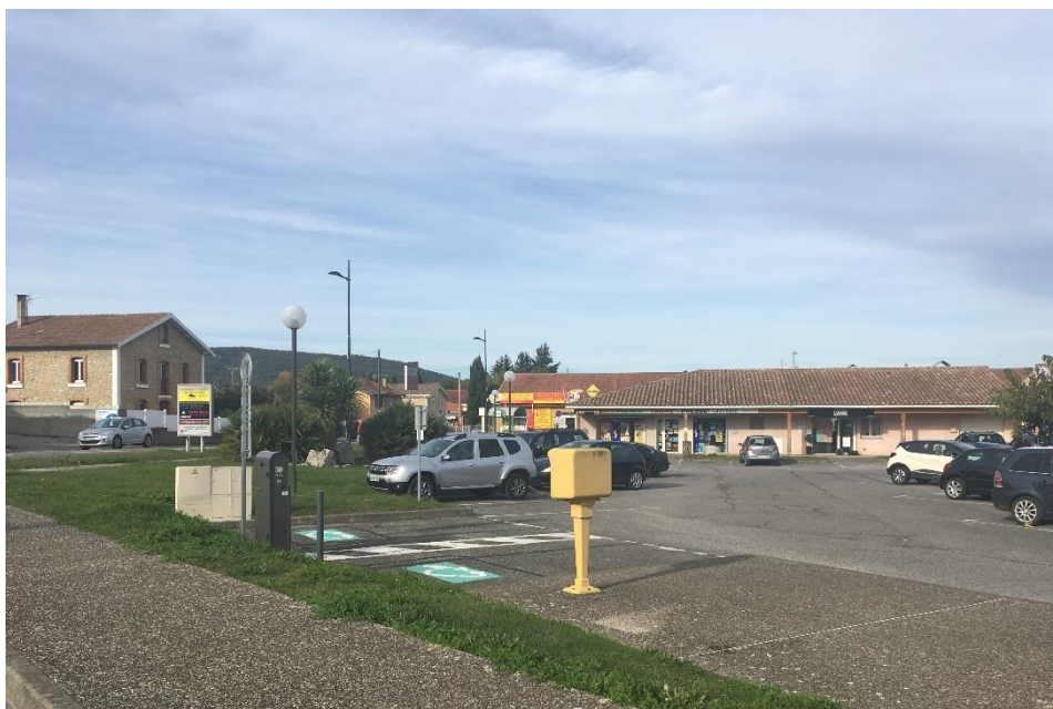
Borne de recharge électrique à Laroque d'Olmes
