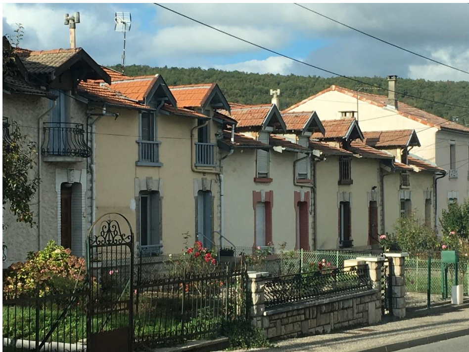
Alignement de maisons ouvrières à Lavelanet
