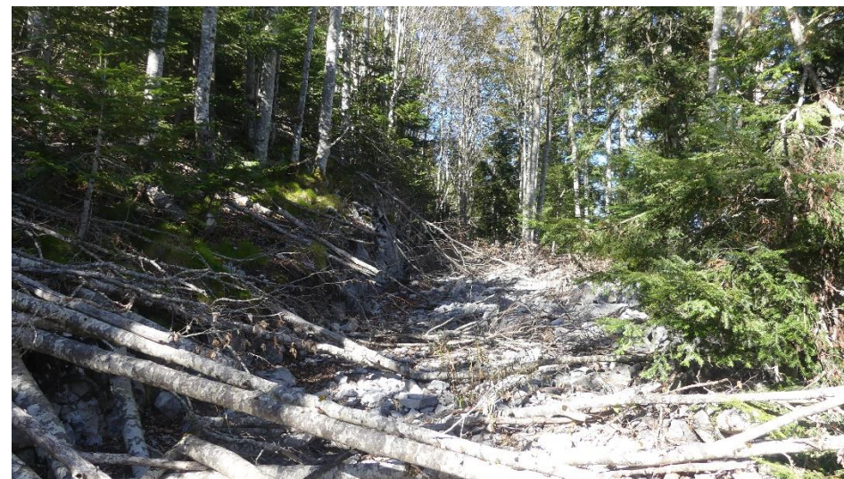
Piste ouverte au sein d'éboulis et andains laissés sur place
