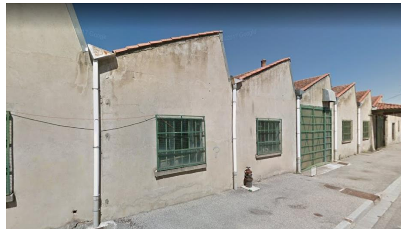
Usine avec une toiture à sheds à Lavelanet
