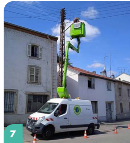
7 < ÉCLAIRAGE PUBLIC > Continuité du remplacement des luminaires de l'éclairage public par du LED. Les tranches 2 et 3 ont été réalisées par l'entreprise INEO. Une 4° et dernière tranche sera réalisée en 2023.
