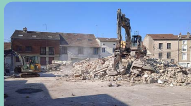
Réalisation des bordures place du Chaldron.
