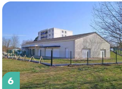
6 < MAISON DU TEMPS LIBRE > Entourage de la Maison du Temps Libre en grillage renforcé pour stopper les dégradations qui étaient très fréquentes et onéreuses.
