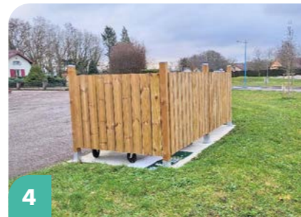
4 < CONTAINERS POUBELLES > Entourage des containers poubelles aménagés avec des matériaux naturels, pour un bel esthétique, réalisé par les services techniques. Fait à la demande de SICOVAD, car les camions n'ont plus le droit d'effectuer des marches arrière dans les impasses afin d'éviter les accidents.
