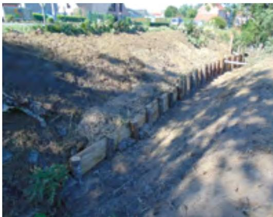
Des travaux de nettoyage et de renforcement des berges de la becque longeant la rue de Bailleul ont été réalisés par l'USAN (Union Syndicale d'Aménagement hydraulique du Nord).
