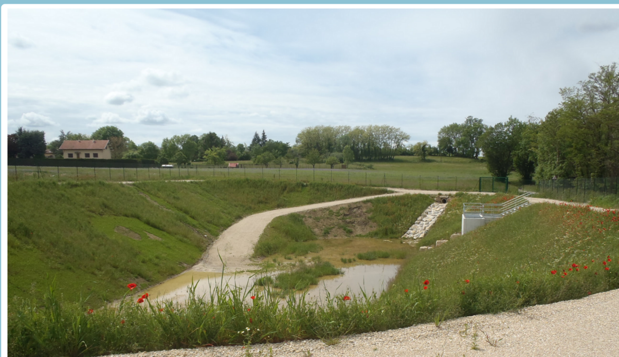
Bassin de rétention des eaux de Comberadix
