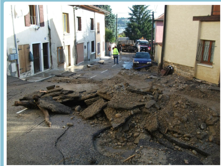
Photo des dégâts causés par l'orage dans une rue du quartier de Comberadix ©Laurent et Gabriel CHEVALIER
