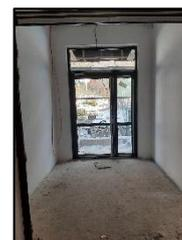
Les travaux de la partie rénovée ont démarré après ceux de la partie nouvelle : les doublages et l'installation des portes et des fenêtres sont terminés.
