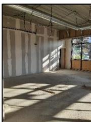
L'aménagement intérieur de la partie nouvelle prend forme puisque l'installation des cloisons est terminée pour faire place à la mise en place du système de chauffage, de l'installation électrique et de l'ascenseur.
