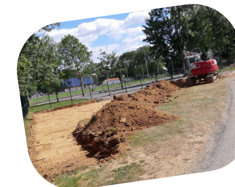
Création d'un parking au terrain de pétanque. Décaissement et engrillonnage.
